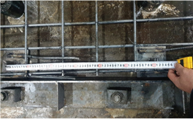
그림 8. 하이브리드 PC 부재 제작 시 매립철물 위치 검수
