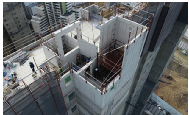
그림 7. 하이브리드 PC 벽체 옥탑 시공 (내판 설치)
