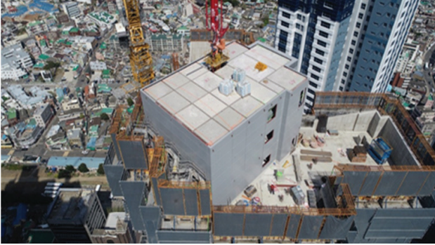
그림 2. 철골 모듈러 공법으로 시공 중인 주상복합 옥탑
