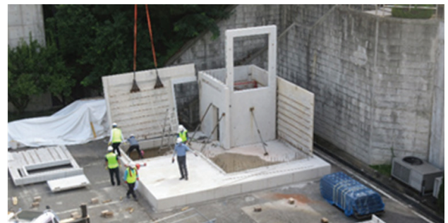
그림 5. 하이브리드 PC 벽체 옥탑 목업 시공
