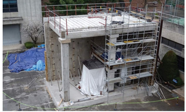
그림 10. 하이브리드 PC 벽체를 이용한 지하 외벽 목업 시공
