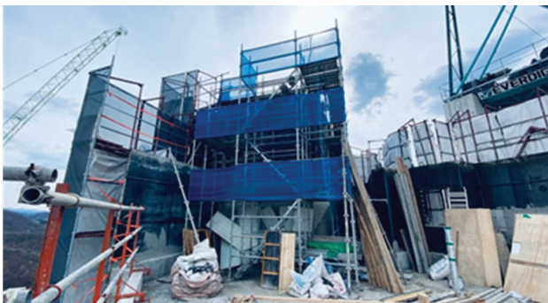
그림 1. RC 공법으로 시공 중인 공동주택 옥탑
