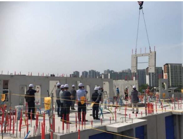
<계단실 측벽 양중 및 조립>
