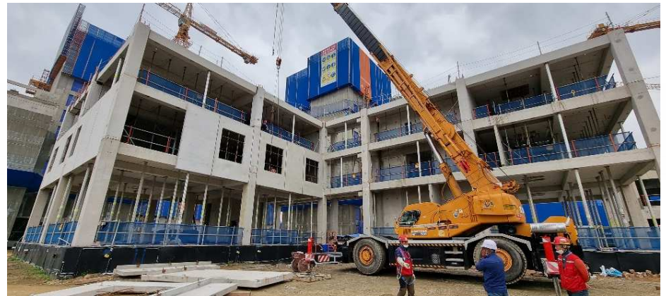
<2층 외벽 PC 커튼월 조립 전경>
