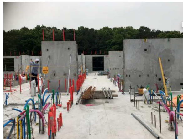
<기준층 벽체 조립 현황>
