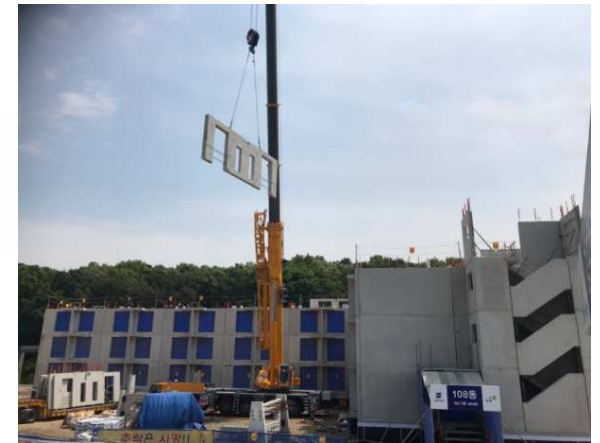
<세대출입구벽 양중 및 조립>
