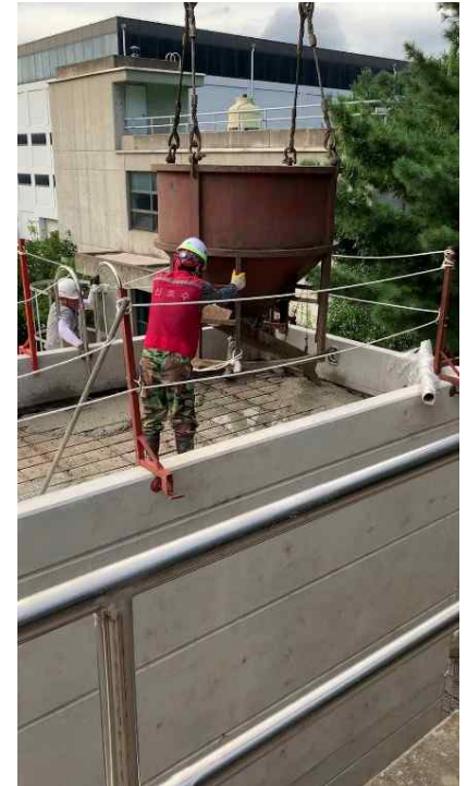
[벽체 및 바닥 타설]
