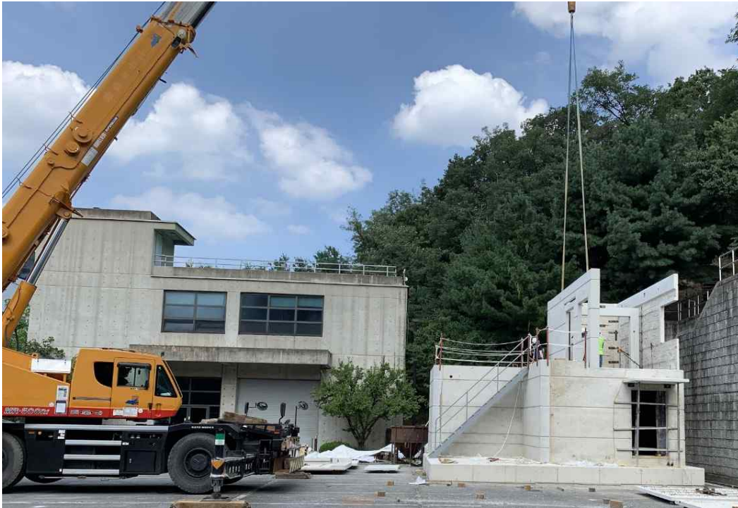
[외부 하프월 설치]
