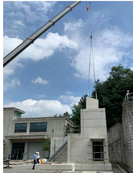
[내부 하프월 설치]
