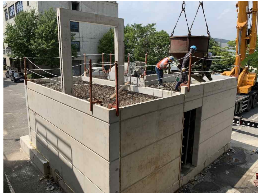
[벽체 및 바닥 타설]
