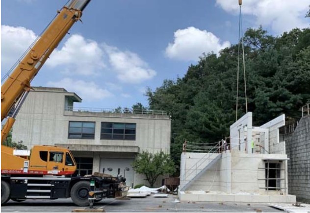
[외부 하프월 설치]
