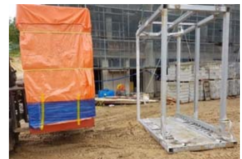
[시스템 욕실 제작 및 목업 시공]
