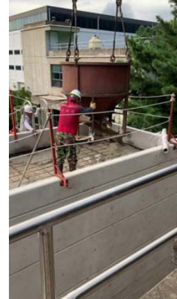
[벽체 및 바닥 타설]
