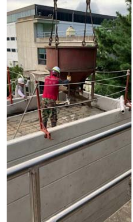
[벽체 및 바닥 타설]
