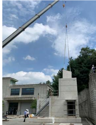
[내부 하프슬라브 설치]
