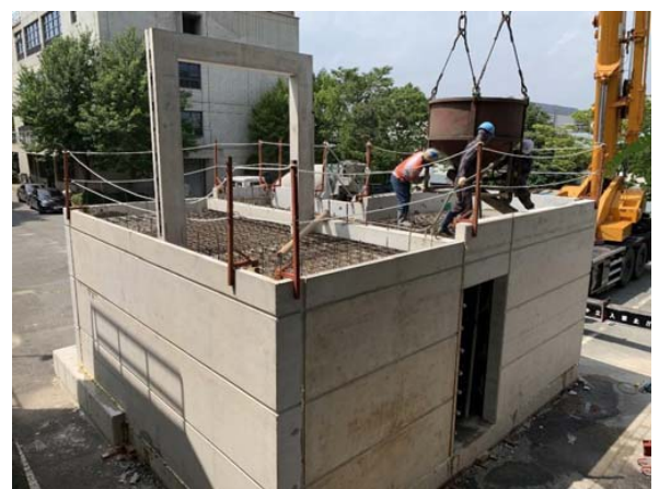
[벽체 및 바닥 타설]
