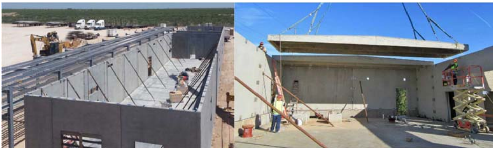
[Easi-Span Roof Panel의 시공 사례]
