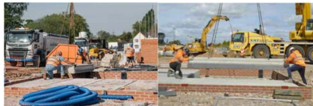
[단열 PC 바닥 시스템 설치]
